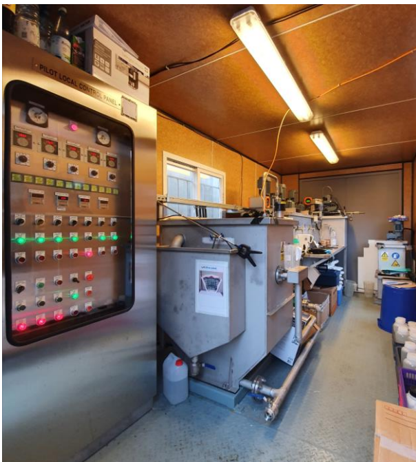
Abb. 2: Installation der Pilotanlage DynaCloth® auf der KA Lahr
